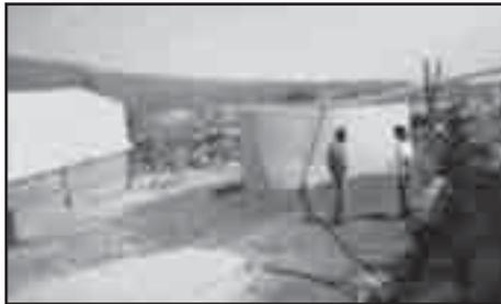
*Cosecha de agua de lluvia de los techos almacenada en cisternas de ferrocemento para la producción de hortalizas en invernadero rústico y a cielo abierto Guanajuato, México*
