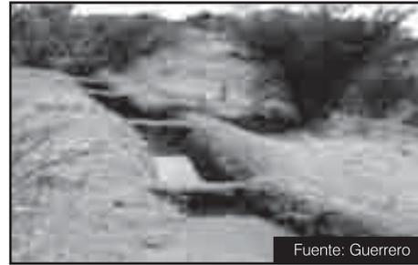
Tabiques en una zanja de infiltración
