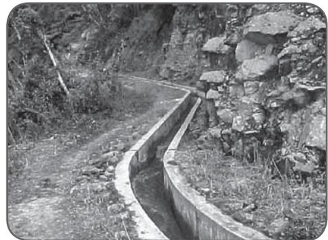
La mayoría de los canales que transfieren agua de la toma del río a la cámara de carga son de tipo abierto, hechos de secciones encementadas (concreto). Cada sección está unida por un material hidrófugo para impedir la pérdida de agua por percolación y dar un mejor acabado a fin de reducir las pérdidas por fricción. También sirve como junta de dilatación.
