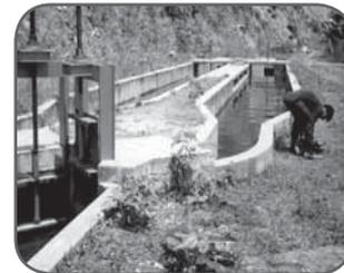
FIGURA 5: VISTA DE PLANTA Y LATERAL DE UN DESARENADOR
